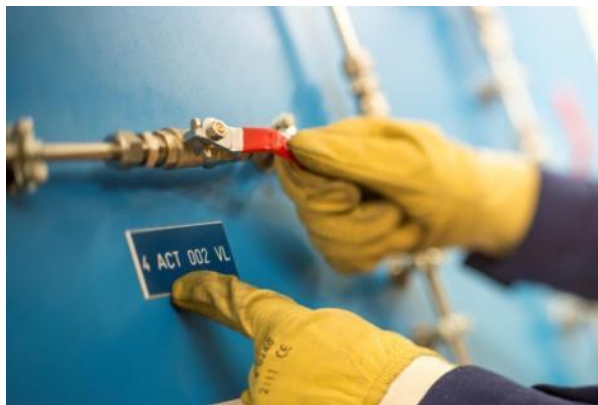
FIG. 3.1 – Étiquetage et repérage des équipements avant intervention
